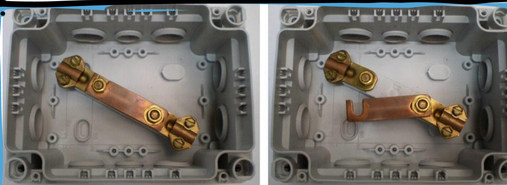
Punto de puesta a tierra, cerrado y abierto
