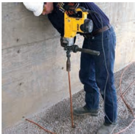
Los electrodos de conexión a tierra pueden insertarse en superficies duras y rocosas con barrenos de martillo para trabajo pesado.
