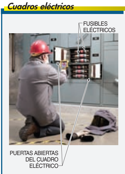
Figura 3-3. Cuando es necesario abrir cuadros eléctricos, deben desarrollarse procedimientos, implementarlos y cumplirlos rigurosamente con el objeto de reducir al mínimo el riesgo de formación de arcos de tensión.
