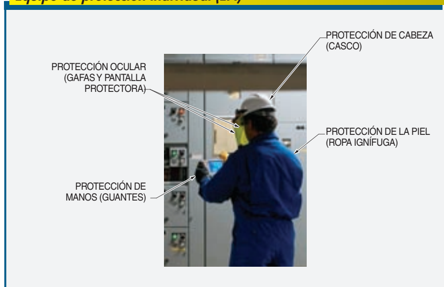
Figura 6-1. El equipo de protección individual incluye protección de ojos, cabeza, piel y manos y está diseñado para amortiguar el posible daño causado por el calor intenso y otros peligros provocados por un arco de tensión.
