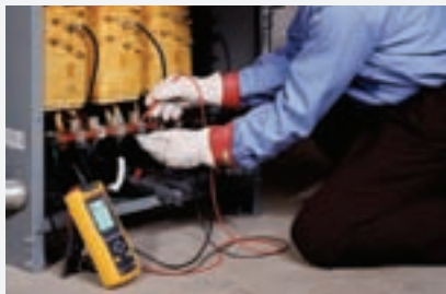
Figura 10-2. El análisis eléctrico hace uso de equipos de monitorización eléctricos para evaluar la calidad de la energía eléctrica suministrada al equipo.
