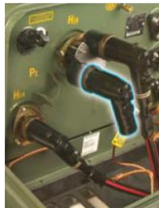
Figura N° 13. Pararrayo tipo codo para cable subterráneo instalado sobre el pasamuro de un transformador.
