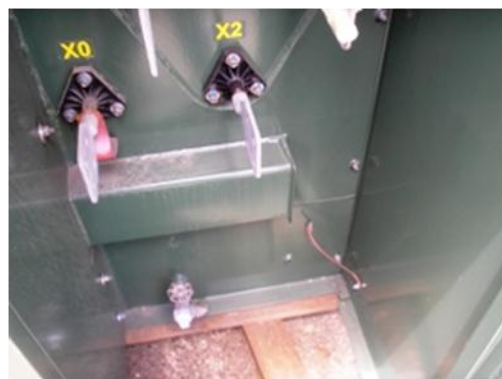
Figura N° 11. Conductor de conexión a tierra de transformadores tipo gabinete en la sección de baja.
