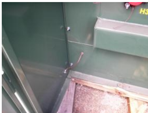
Figura N° 10. Conductor de conexión a tierra de transformadores tipo gabinete en la sección de alta.
